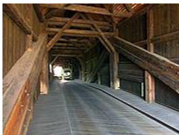
Blick in die Wünschendorfer Holzbrücke
